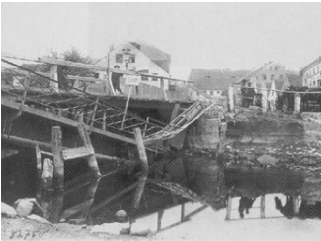
Zniszczony most na ulicy Grunwaldzkiej
