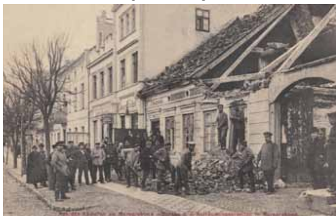
usuwanie zniszczeń wojennych w Margrabowej
