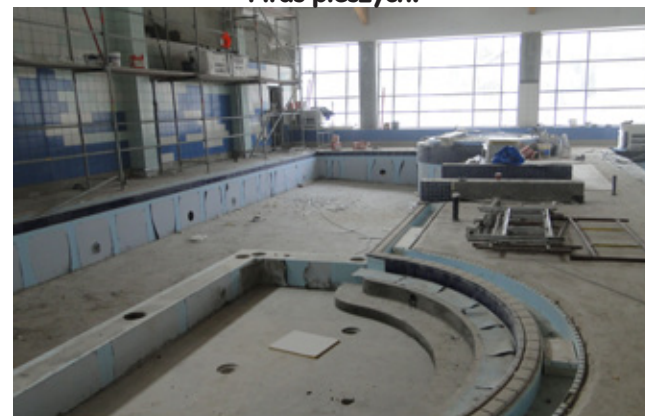
Prace przy budowie ogromnego dżakuzi
