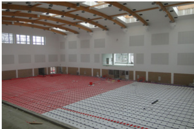
Układanie paneli centralnego ogrzewania posika głównej hali widowiskowej
