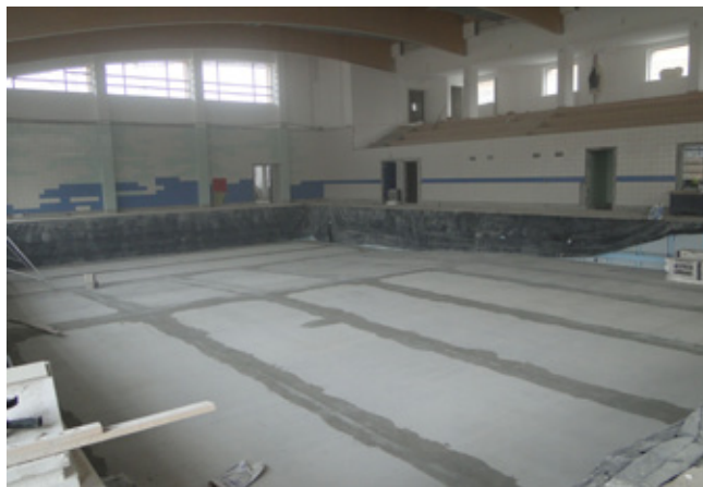
Budowa baseny pływackiego
