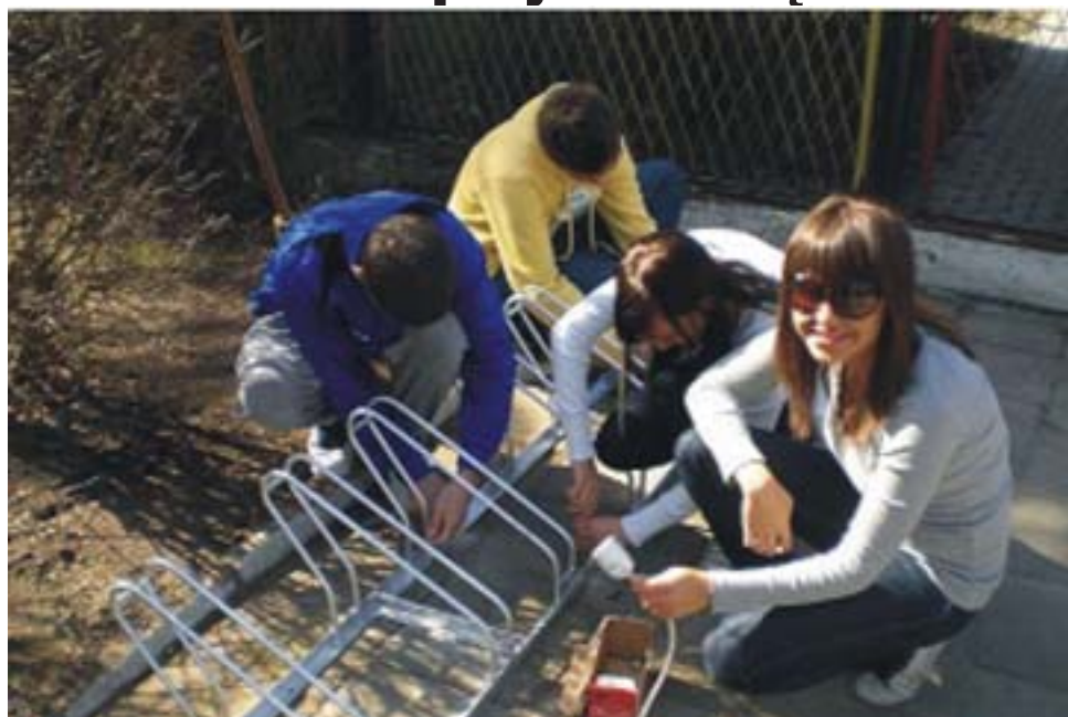
Fot. Uczniowie klasy 2c montują stojaki na rowery przed budynkiem szkoły.
