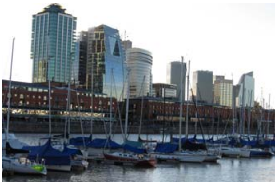
Nowe budowle w stolicy.
